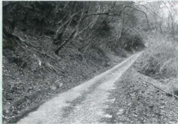
村道荒谷2号線延長120m改良予定
