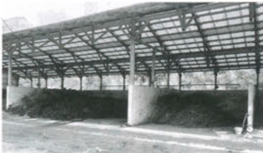
畜産センター 堆肥舎
