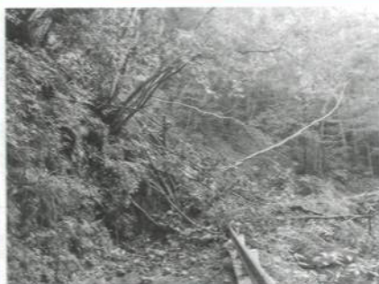
山中水源地付近崩壊地
