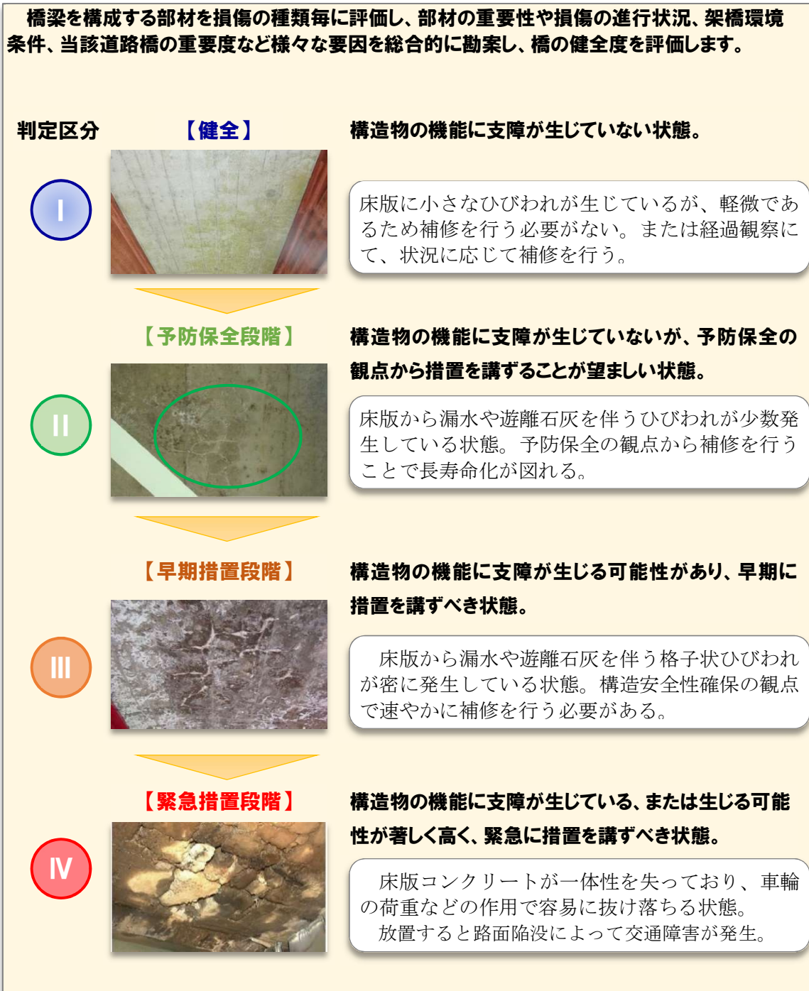
図 13 橋の健全度の事例
