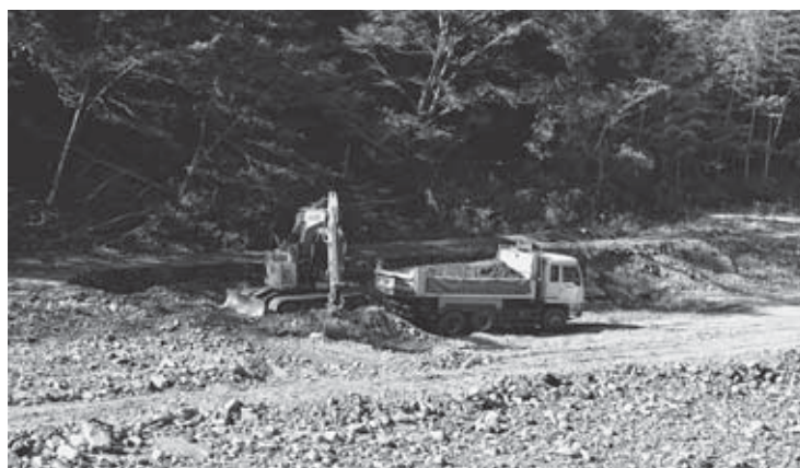
轟八重対岸土砂除去状況
