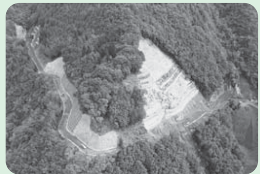
小川・石打谷線 未開設区間134.2m
