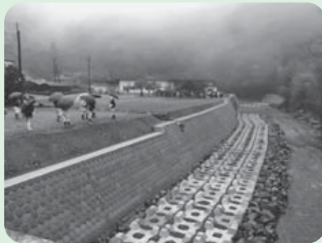
八重護岸工事
