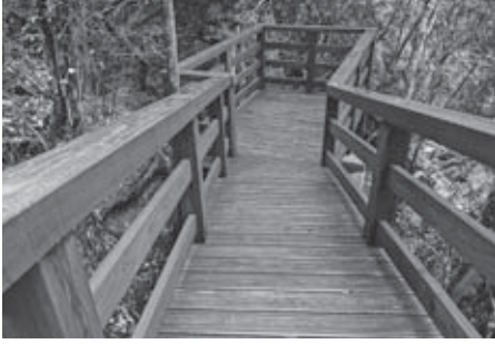
改修後の蛇淵デッキ
