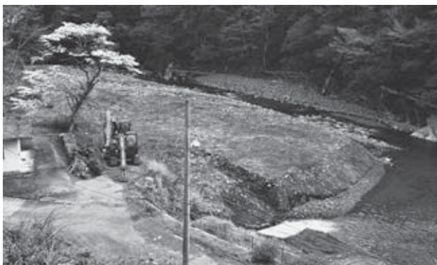
<板谷堰堤付近>
