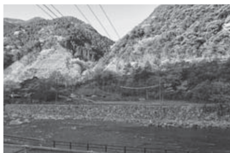
＜カリコボーズの宿嵩上げ工事＞
