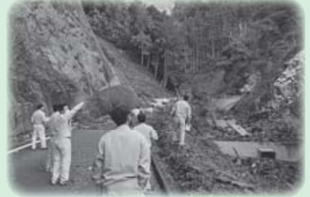
③村道小川・石打谷線
