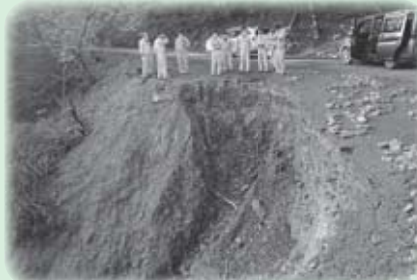
⑤村道米良・椎葉線2号箇所
