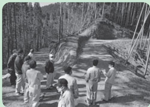
①板谷地区、吉村谷 村分収林伐採及び作業道開設状況
