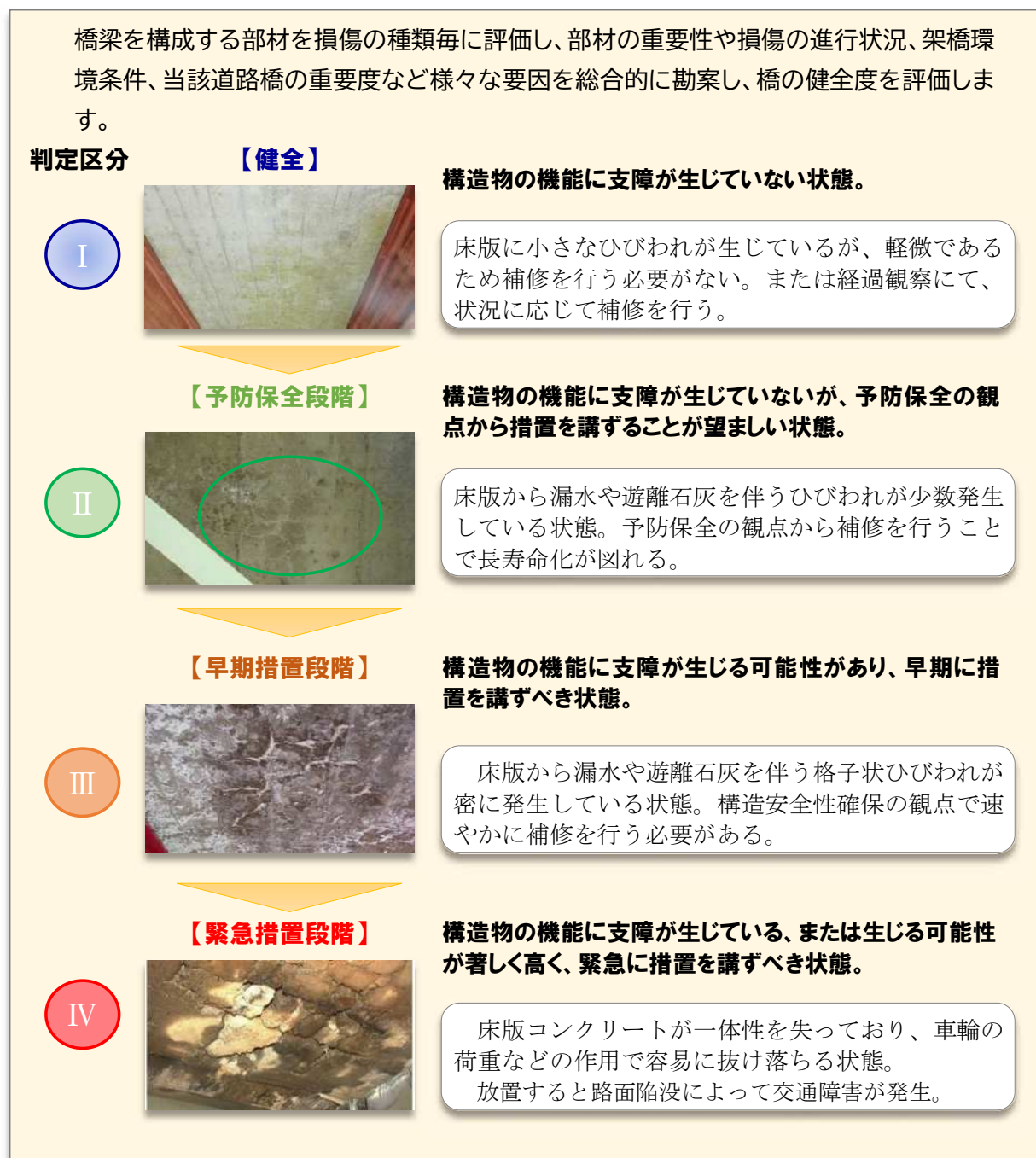
図 13 橋の健全度の事例 (判定 I～IV:道路橋定期点検要領 国土交通省 道路局)
