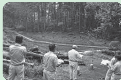
県営長藪復旧治山工事の 残土処理場(天包山)
